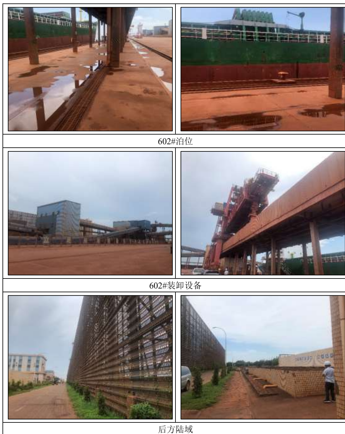
图 3.3-1 现有项目现场照片
